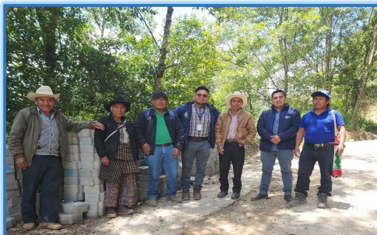
Fuente: Propia FODIGUA. Apoyo con la dotación de materiales para el mejoramiento de la infraestructura vial, Sector Tuy, Caserío San Francisco Aldea los encuentros, municipio de Sololá, departamento de Sololá, julio 2025.
