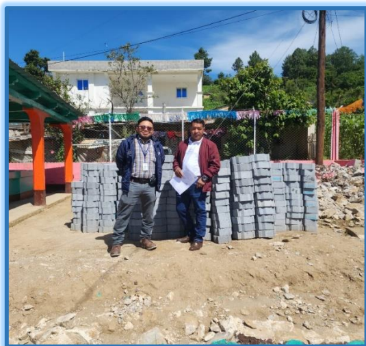
Fuente: Propia FODIGUA. Apoyo con la dotación de materiales, para el mejoramiento de la infraestructura vial, Caserío Centro de la Aldea la Esperanza, municipio de Totonicapán, departamento de Totonicapán, julio 2025.
